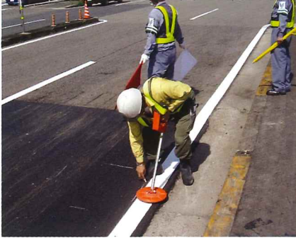
① 仮蓋電磁探査
