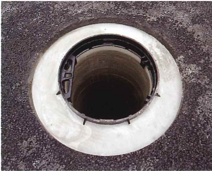
④ 無収縮モルタル打設完了
