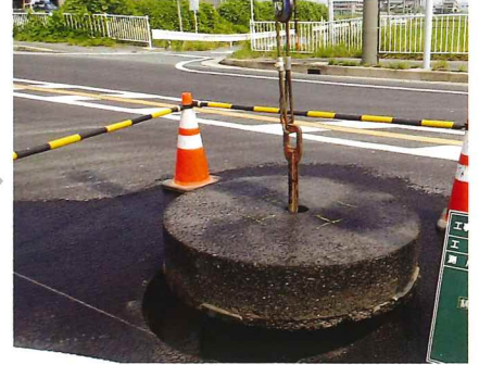
③ 舗装版撤去
