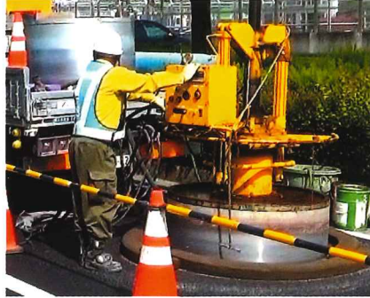
② 舗装版切断
