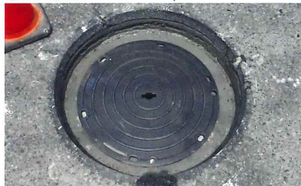
④ アスファルト転圧
