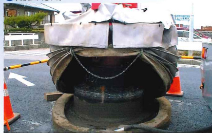
② マンホール撤去
